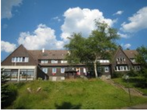
Haupthaus von außen
